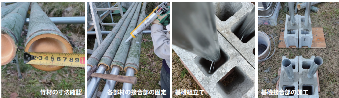
写真_組立試験の様子
